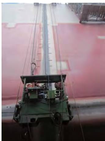
立向突合せ自動溶接機（EGW）
